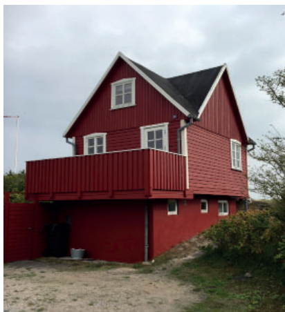
Den søjlebårne del af huset er med tiden blevet fyldt ud med en underetage. Sommerhus beliggende på selve klitkronen.
